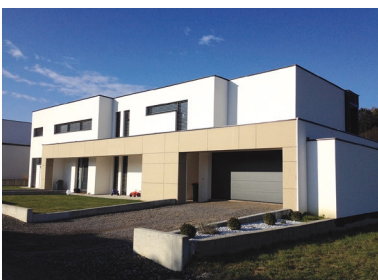
Mit Austrotherm Produkten gedämmte Fassade
